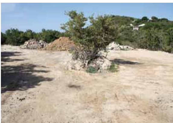
1000m 2 déjà remblayé
